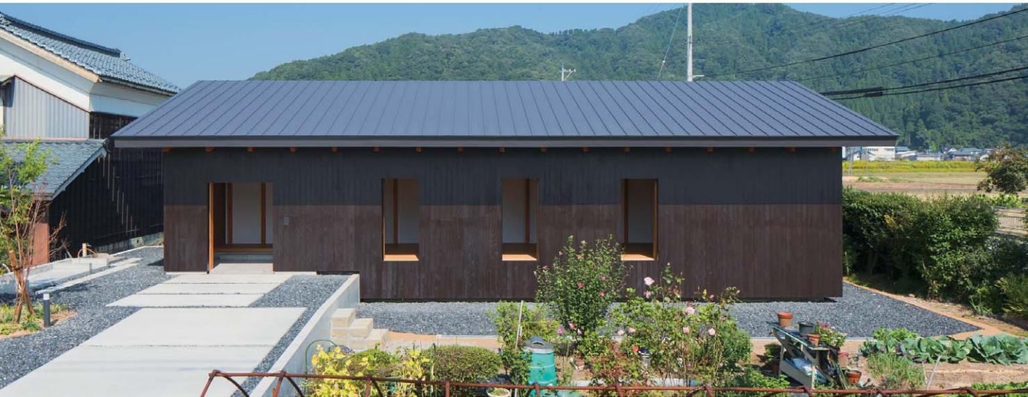
南側立面。外壁は杉板縦張りオイル仕上げ。開口部の既製品引き違いアルミサッシを開け放った様子。田園から吹き抜ける風、交差点の車からの視線に配慮し外壁の中には雨戸、ブラインドが納められている。
