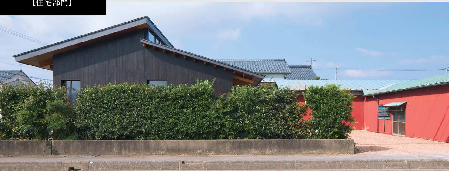
東側立面。県道から既存の生垣越しに見る。右手赤い建物が既存建物の車庫と倉庫。屋根を既存建物の3寸勾配に合わせ、建物中央で1m程度段差をつけてスリットから北側の光を建物内部に取り入れている。
