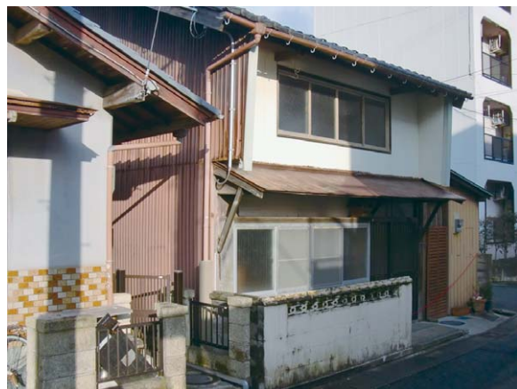
改修前東側外観
