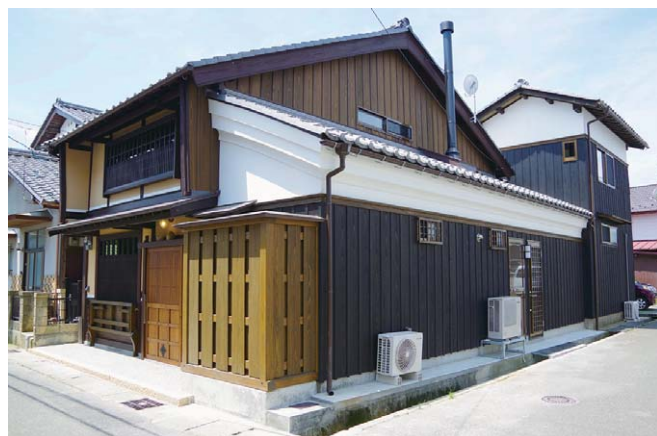
改修後北側外観
