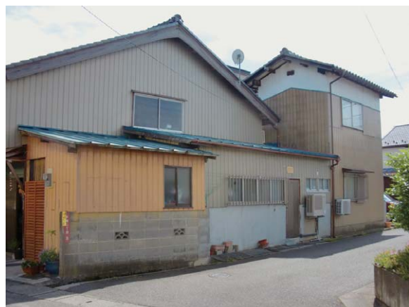
改修前北側外観
